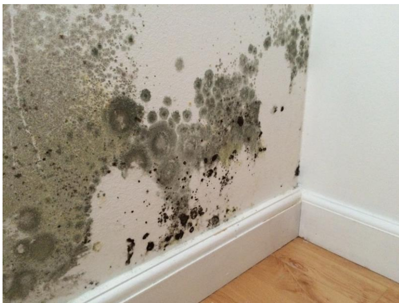
Figur 1: Synlig vækst af skimmelsvampe. Foto: Teknologisk Institut.
